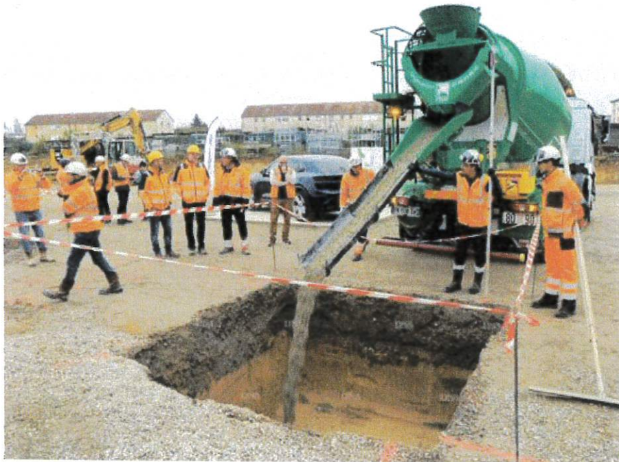
Coulage des fondations avec du béton bas carbone issu de déchets par l'entreprise Fehr dans le cadre du chantier de la nouvelle concession Porsche à Bischheim. Photo J.-M. Loos
